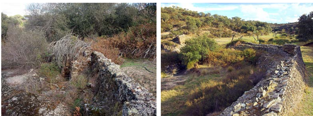
Figuras 18 y 19. A la izquierda, presa de contrafuertes del molino conocido como «de la Señora Montinegra», cercano a Garrovillas, con un interesante sistema hidráulico. A la derecha, restos de presa en arco en el arroyo Morisco; ambas presas llevan aparejados interesantes sistemas hidráulicos, incluyendo molinos harineros. Pensamos que son anteriores al siglo XVIII.
