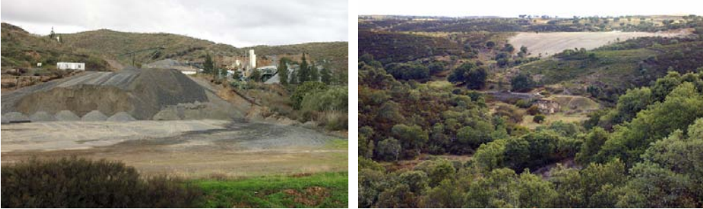
Figuras 23 y 24. Planta de extracción de áridos a escasos metros del puente romano. A la derecha una de las presas históricas de Garrovillas, rodeada de encinas y un vertedero en sus inmediaciones.
