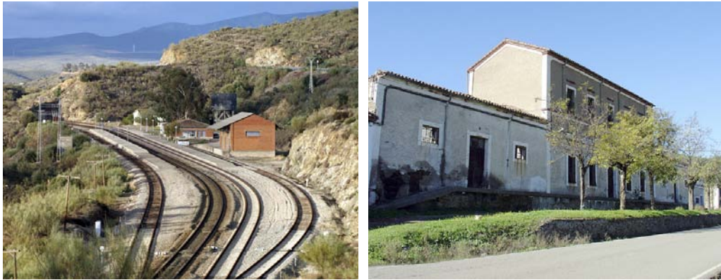
Figuras 20 y 21. Actual estación de Río Tajo, de RENFE. A la derecha, fábrica de harinas en el barrio de la estación, en Cañaveral 25 .
