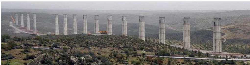
Figura 13. Labores de construcción del viaducto de Valdetravieso.
