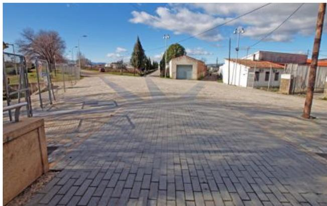
Figura 11. Diseño del pavimento en la margen derecha, a la salida del puente, distinguiendo los ejes camineros.
