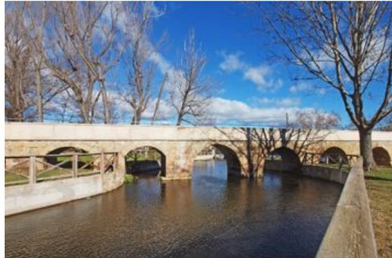
**Figura 4.** El canal, bajo el puente Antiguo rehabilitado. El cauce natural discurre bajo siete arcos; existen dos más sobre la isla; tres más en el canal, observados en la foto, y otros dos ya en seco.
